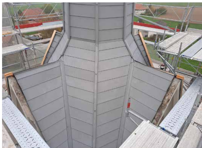
L'ajustement des tôles est un travail délicat.
